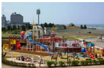
子海族船サンセット号 (防災備蓄倉庫)
