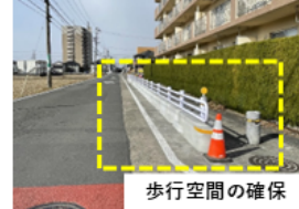
【（対策例）ガードパイプ設置】
