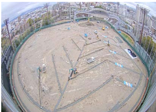
改修中のグラウンドの様子
