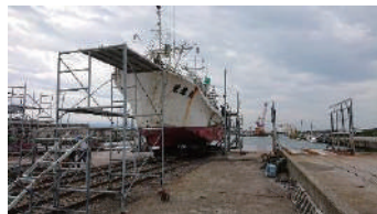
大型漁船用上下架施設
