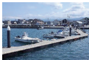
経田漁港の浮棧橋
